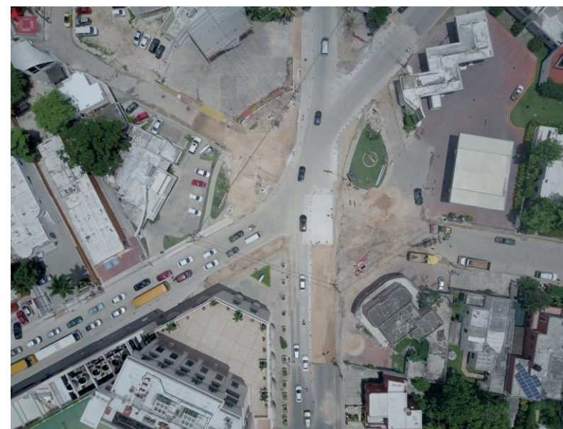
Modernización de Av. Colón y calles anexas Mérida, Yucatán, MX Febrero, 2018
